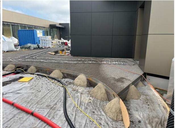
Profileinbau ohne Erdanker im Betonfundament (Punktfundament)
