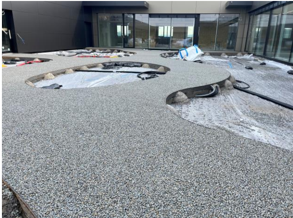
Profileinbau ohne Erdanker im Betonfundament (Punktfundament)
