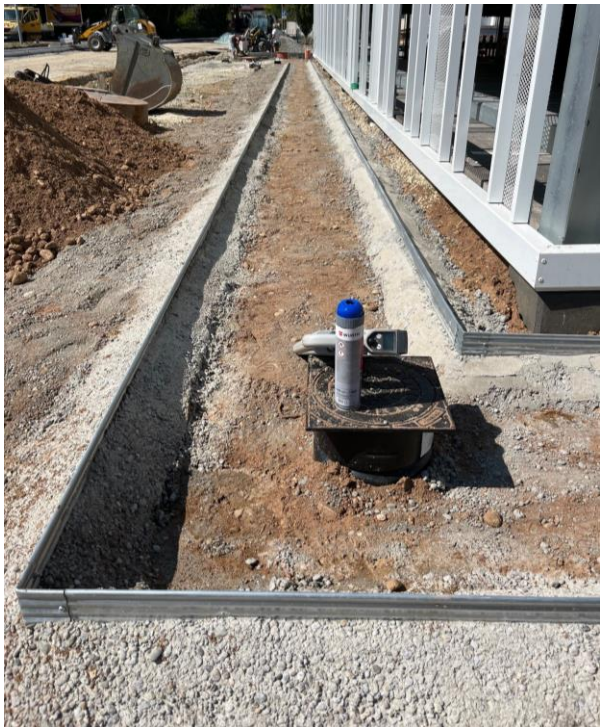
Profileinbau ohne Erdanker im Betonfundament (Streifenfundament)
