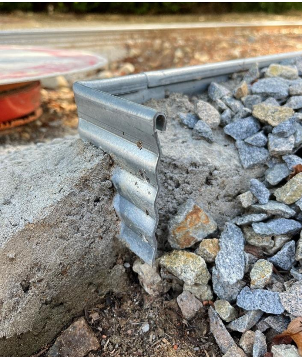
Profileinbau ohne Erdanker im Betonfundament (Streifenfundament)
